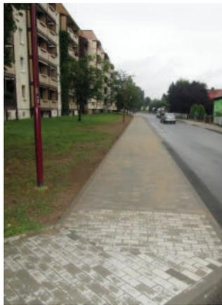
gen Ganitborde ausgebaut, der Untergrund bis zu einer Stärke von 40cm ausgekoffert, 115 m Betonhochbord als Straßenbord und 115 m Tiefbord als Rücklagebord versetzt, um die 90 cm
