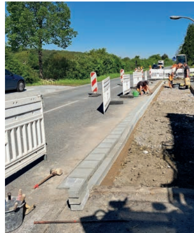
Bauarbeiten, Neuer Weg Neuseußlitz
