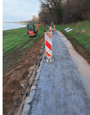
letzte Arbeiten an Böschung und Bankett
