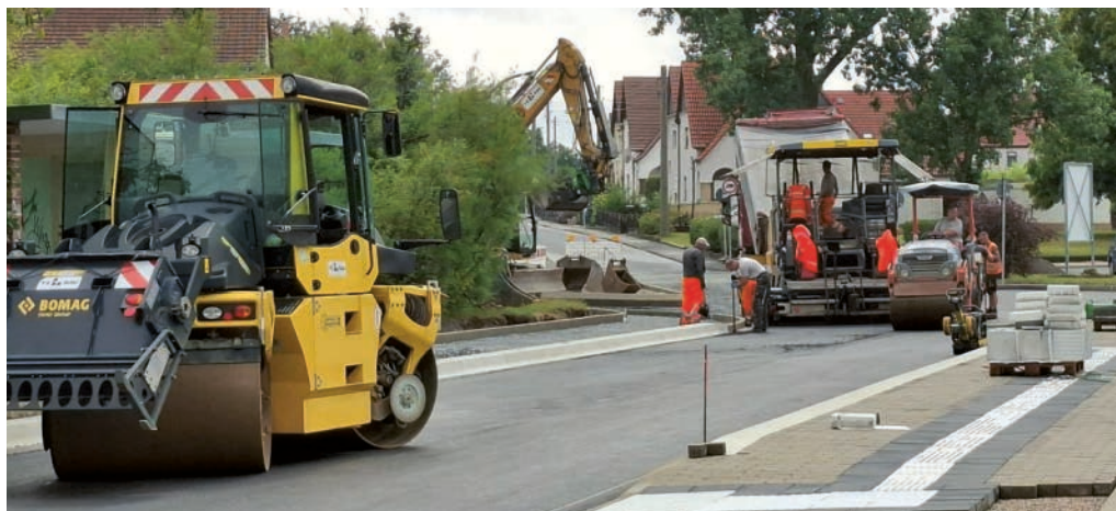
Bild 1: Bauarbeiten Asphaltsteinbau am Heyden-Platz
